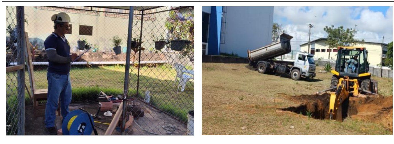
Figura 5 - Teste de bombeamento do poço em Óbidos e Construção de sumidouro no RU.
