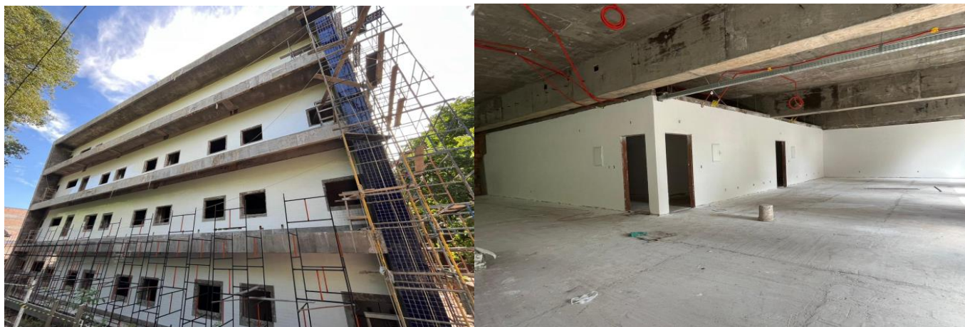
Figura 8 - Imagens da fachada lateral e parte interna do Bloco Modular do Tapajós, Etapa 3.
