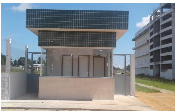
MURO E GUARITA DE JURUTI
