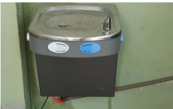
INSTALAÇÃO DE BEBEDOUROS ACESSÍVEIS
