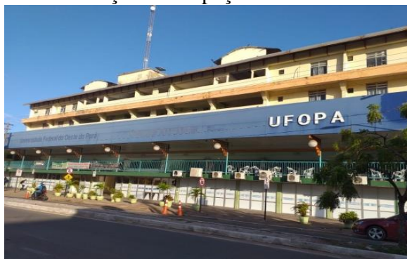
5º ANDAR DO PRÉDIO PRINCIPAL DESALUGADO
